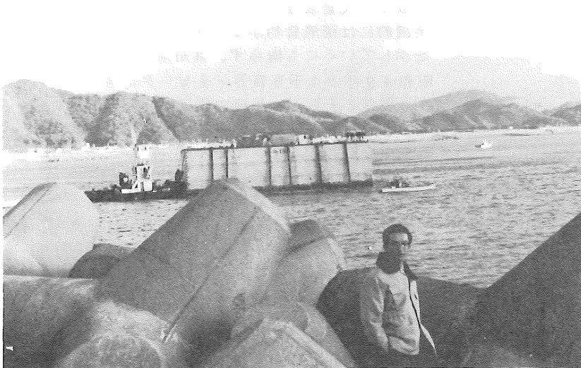
写真-1 桂浜防波堤先端付近を曳航されるケーソン
