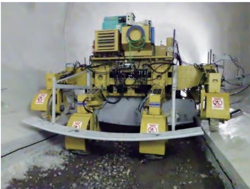
写真-5 スリップフォーム工法による機械化施工
