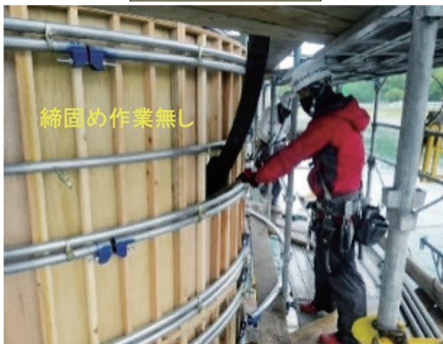
打設孔からの充填
