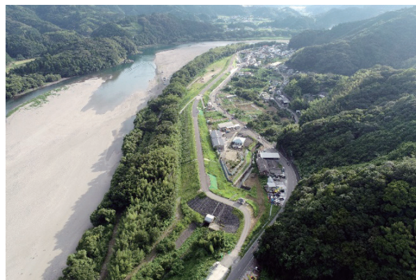
写真-4 仁淀川加田堤防
