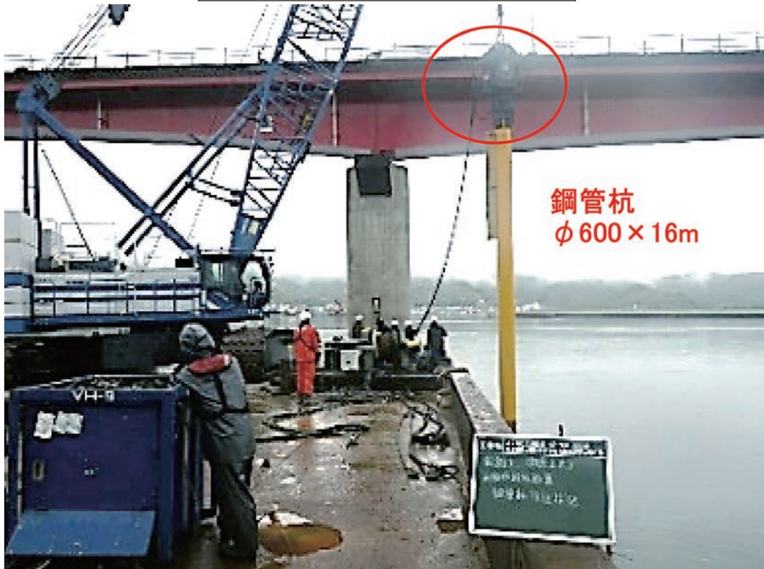
バイブロハンマーによる鋼管杭打ち込み
