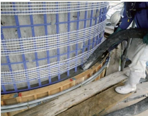
高流動コンクリートの打設
