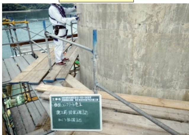
橋脚表面観察
