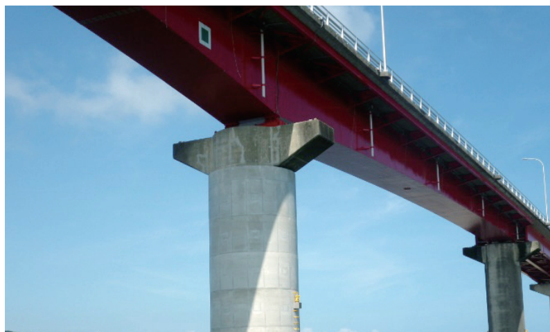
宇佐大橋：昭和48年12月完成 橋脚耐震工事
