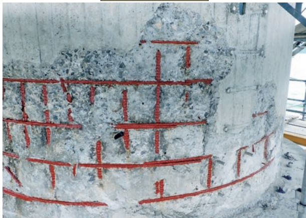
鉄筋防錆処理
