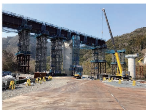
写真5 横倉大橋の施工状況
