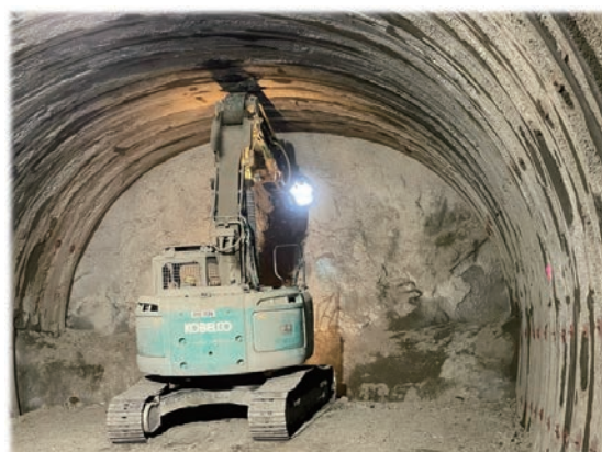
写真3 横島トンネル貫通
