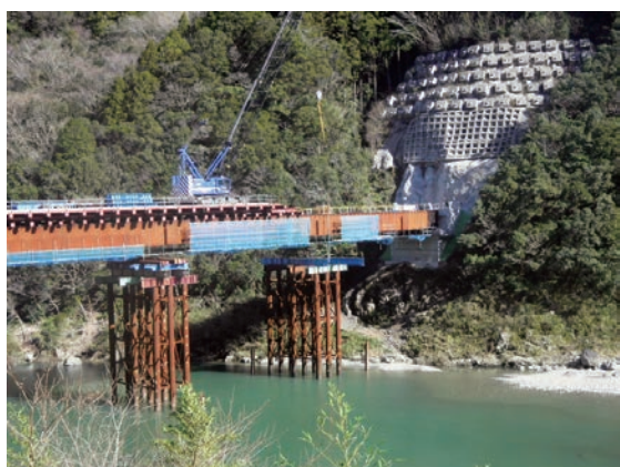
写真4 立花大橋の施工状況
