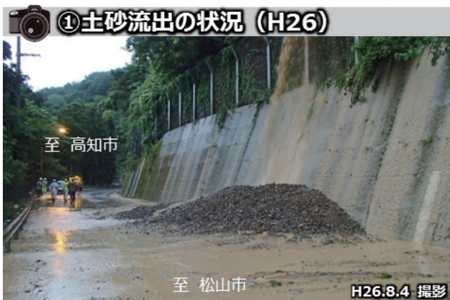
写真6 土砂流出の状況 (H26)
