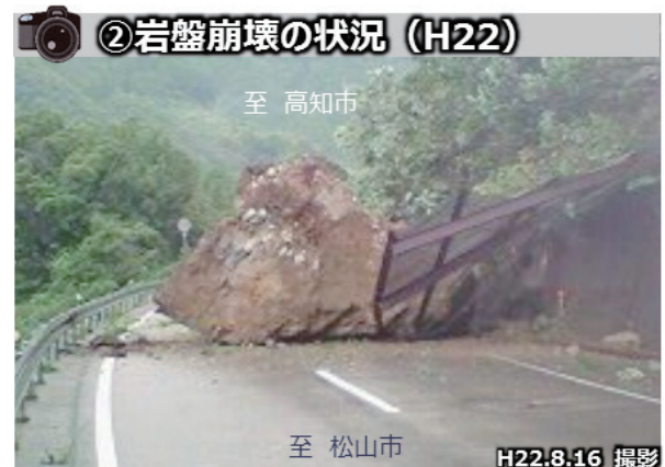
写真7 岩盤崩壊の状況 (H22)
