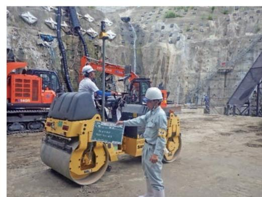
写真-8 4t振動ローラによる転圧作業
