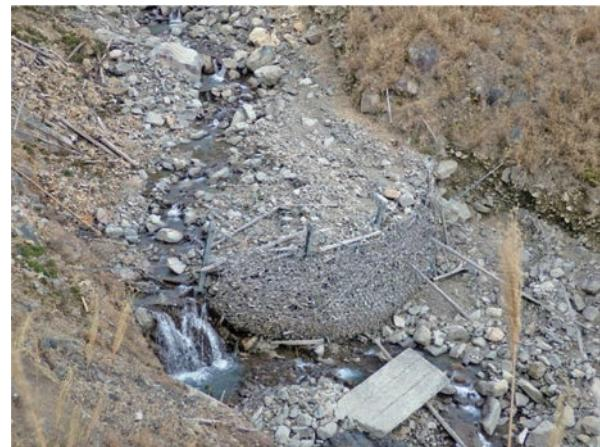
写真-3 仮設砂防堰堤による土砂の補足（H26年）
