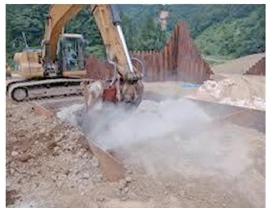
写真-6 バックホウによる攪拌混合
