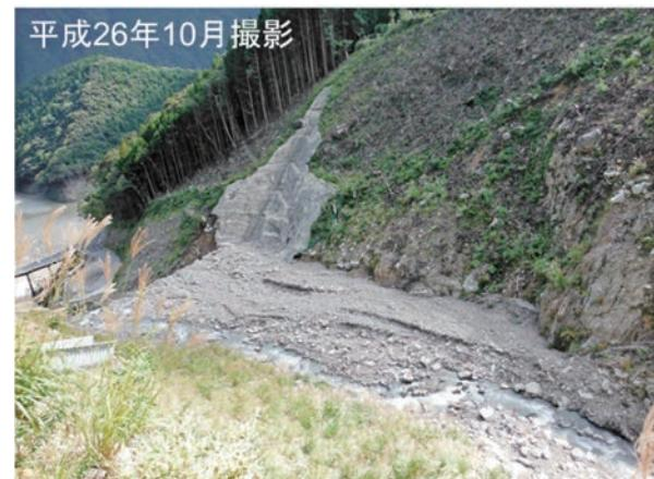
写真-4 工事中の堰堤による土砂の補足（H26年）
