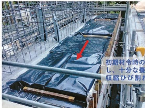
初期材令時の水分蒸発を抑制し、十分な養生が行え、乾燥収縮ひび割れの発生を防止
