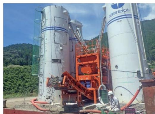
写真-7 製造プラントによる攪拌混合
