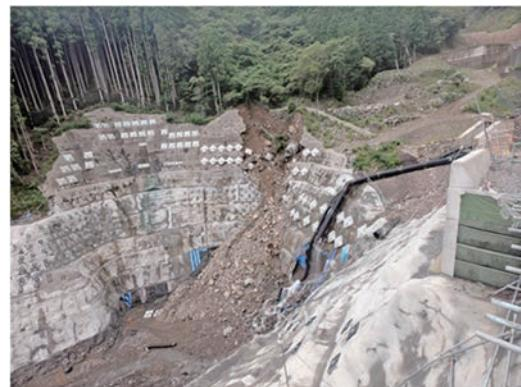
写真-5 挖削法面の崩壊状況 (H30年)
