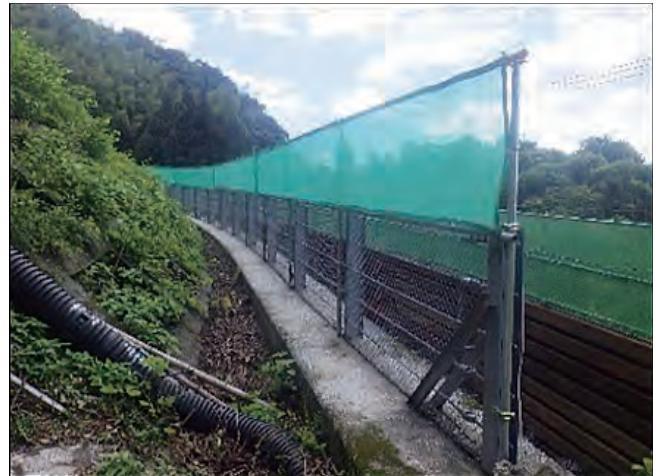
図8 落石防護ネット（仮設防護柵上部）
