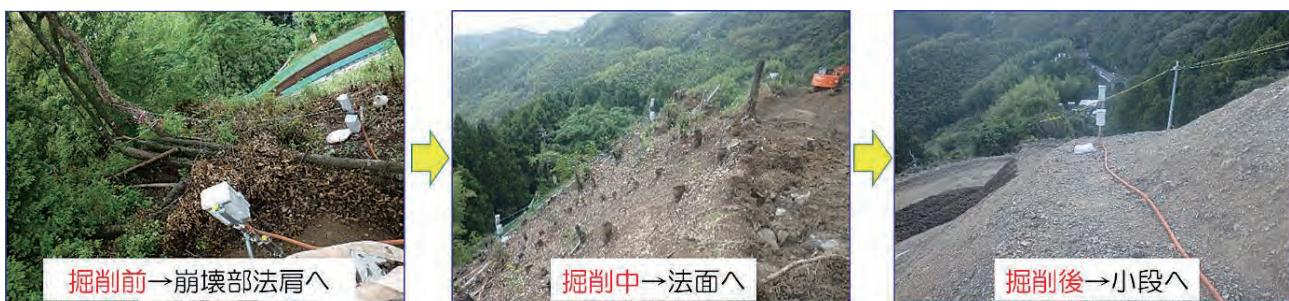
図6 「ばらまき型」 傾斜計（掘削作業の進捗に合わせて移動・再設置）
