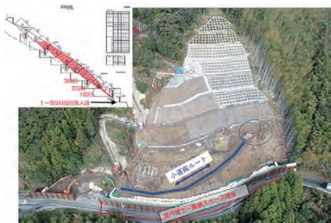
図7 最下段部の大型土のう設置状況
