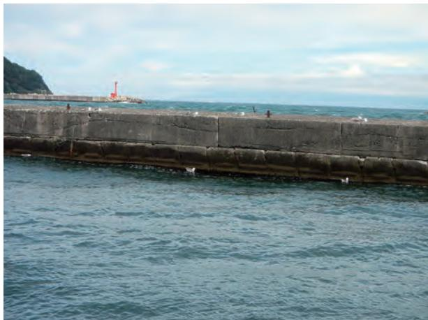
写真-5 北防波堤の斜塊ブロック
