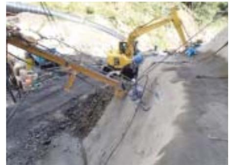
写真-9 鉄筋挿入工
