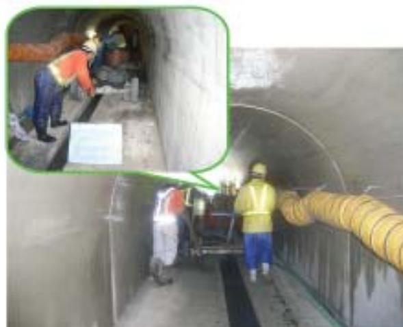
写真 坑内運搬台車使用状況
