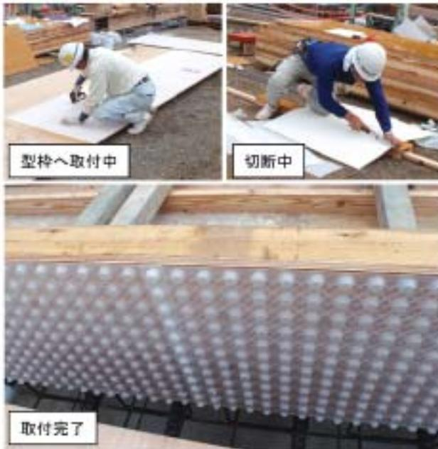
写真-1 K Kシート施工状況
