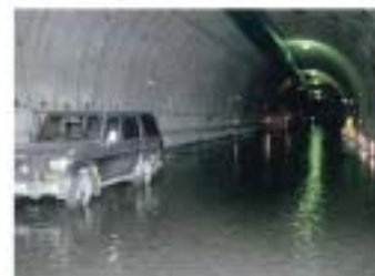
出水でプールようになったトンネル内
