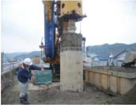
地中障害物撤去状況(BG工法)
