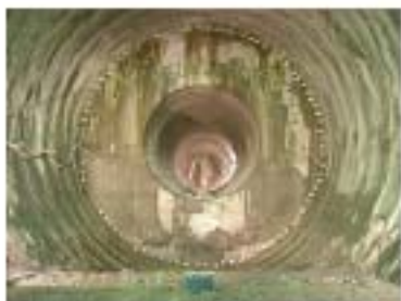
実際に施工した円形支保工と中央導坑先進工法
