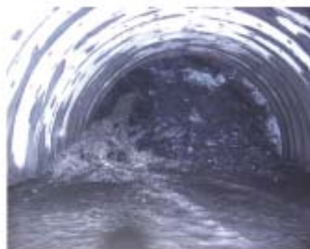
毎分20tの突発異常大出水が発生
