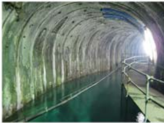
完成した水抜き坑 (清濁分離坑)
