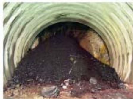
切羽上部から大量の土砂が崩壊
