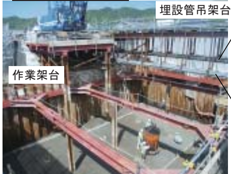
作業構台、埋設管架台
