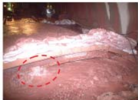
盤ぶくれでストラットが約1m突き上げられた状況 赤破線の円内は湯水噴出状況
