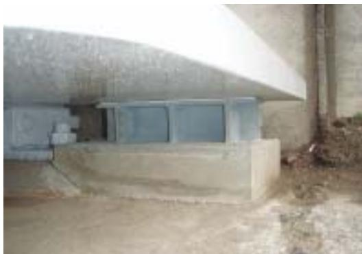
落橋防止装置工・変位制限装置工は鋼製ブラケットでの耐震補強です。
