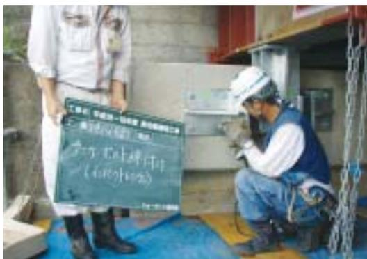
現場塗装工では本設計のRc-1系塗装は、全面ブラストによる素地調整による塗り替え仕様で、その研掃材が硅砂となっていました。作業者の硅肺等による健康被害防止の為、また粉塵発生を抑える為に、他の研掃材と試験施工を実施し、ガーネットでのブラストに変更して作業しました。
