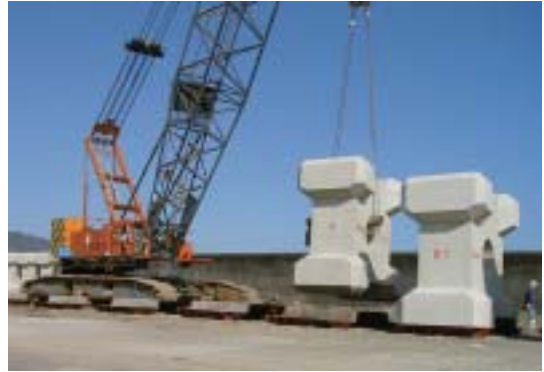
写真-2 吊上げ作業時状況
