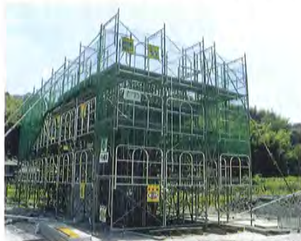
手摺先行型足場
