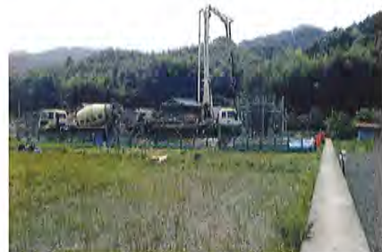
コンクリート打設
