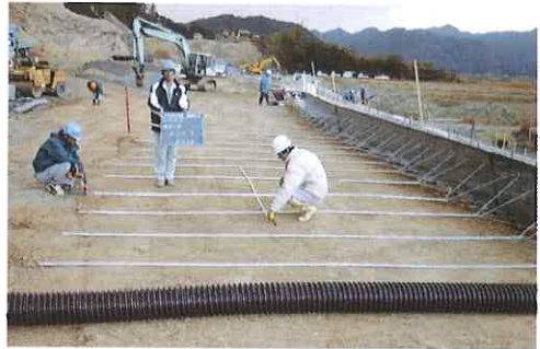
補強土壁工
