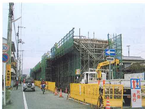
愛宕踏切東側126 K 851 m付近（南側道路より）
