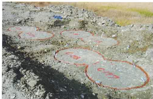
地盤改良工後
