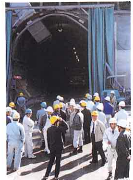
11/19 新宇治川放水路トンネル
