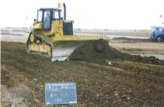
盛土敷均し状況
