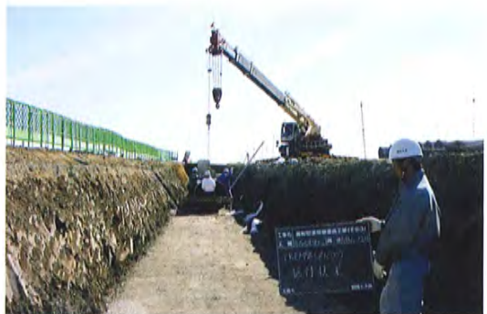
F R P M管据付状況
