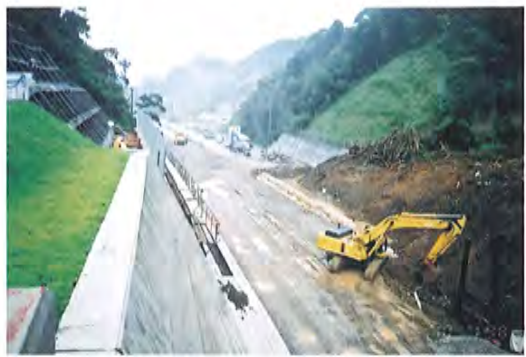
写真-4 プレスト管の上に路床碎石を敷均した状況。鋼板を全面に敷いてアスファルト舗装を施工する。
