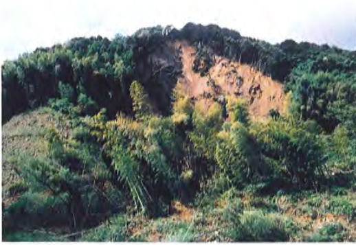
写真-1 山腹崩壊状況
