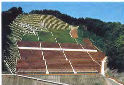
写真-5 工事完成の全景
