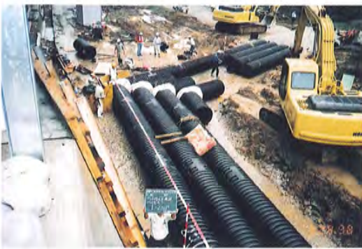
写真-3 水路のバイパス、プレスト管布設状況
