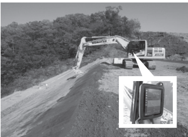
図-3 ICT建機による法面整形
