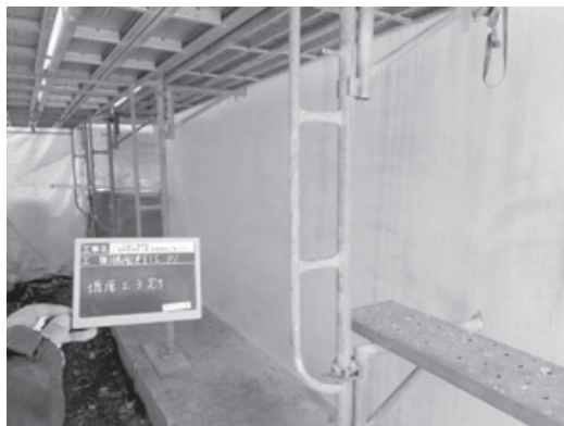
図-8 養生撤去完了時
