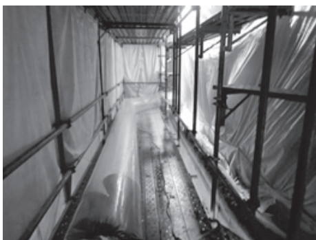
図-7 夜間の養生
