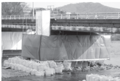
図-3 足場外部養生
