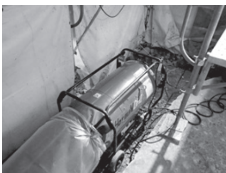
図-6 ジェットヒーター設置
